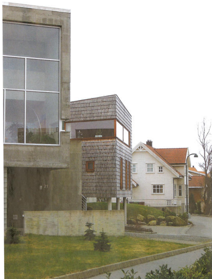
Tresponkledningen står for seg – midt mellom naboens tradisjonelle hvite panel på den ene sida og betong og glass på den andre.
